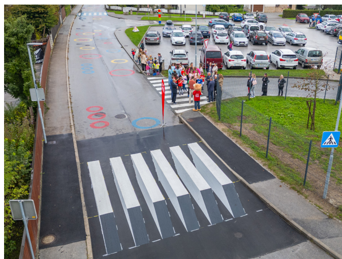
Talne oznake na vozišču ter 3D oznaka prehoda za pešce v neposredni bližini PŠ Lavrica (Foto: arhiv občine Škofljica)
